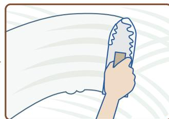
ウチカベースが完全に乾燥した後に、各種の上塗り材で仕上げ作業を行います。
